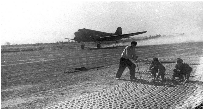
Будівництво злітно-посадкової смуги з металічних решіток на аеродромі Марково
